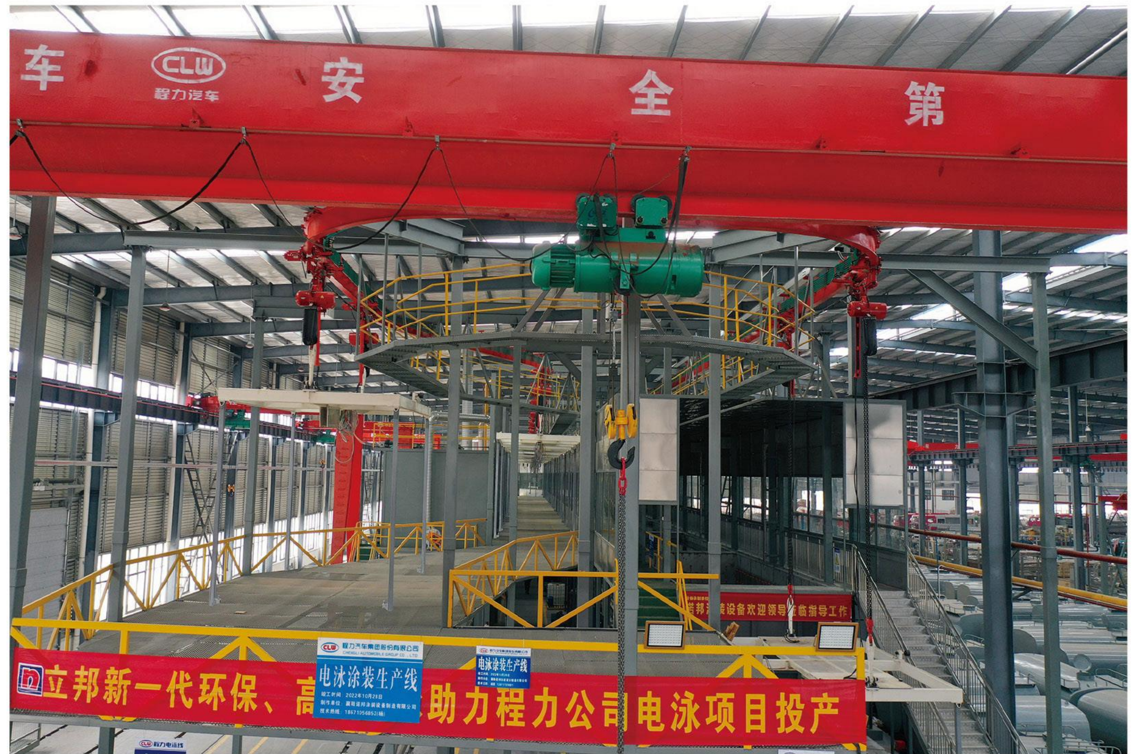
电泳涂装生产线-5
