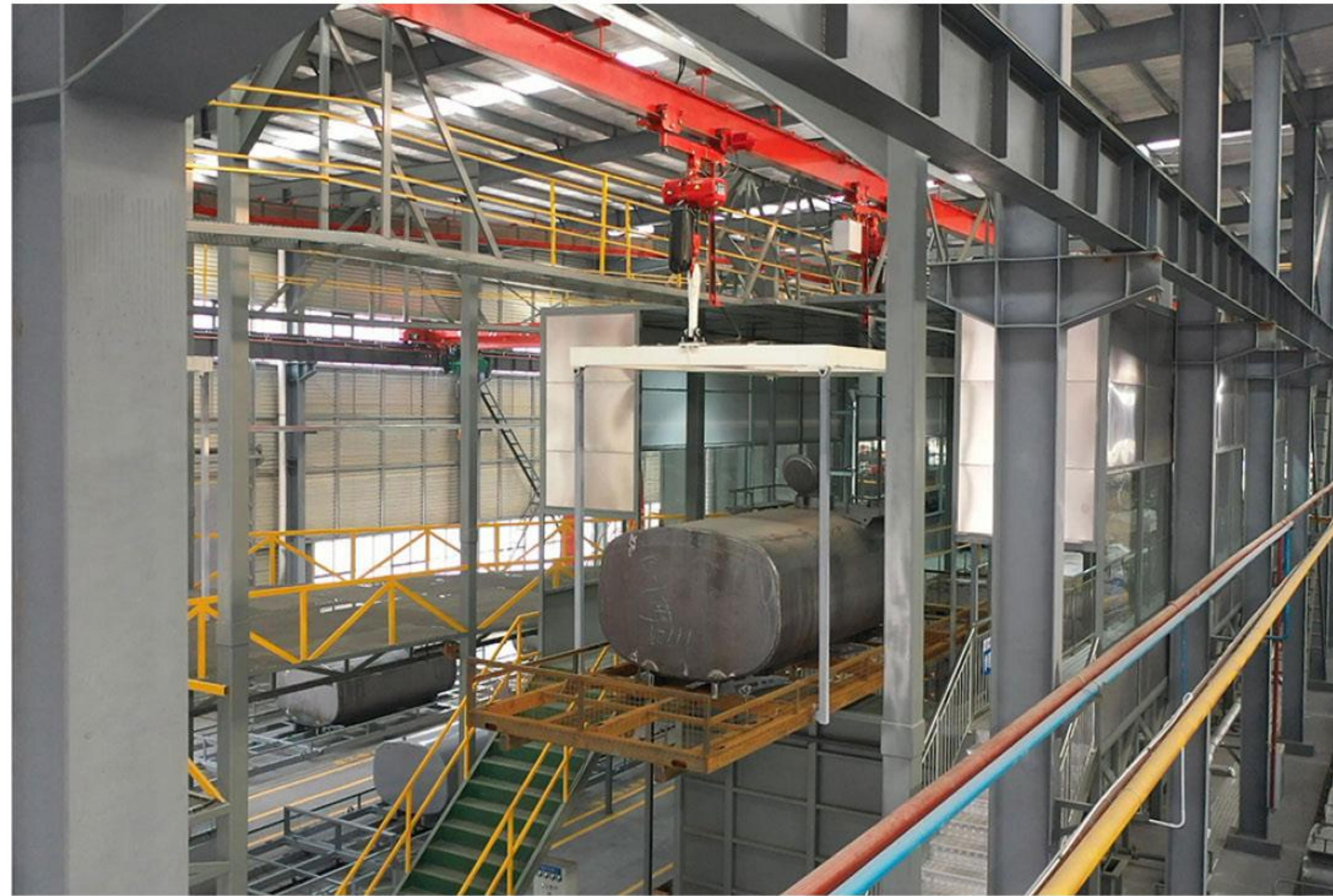
电泳涂装生产线-1
