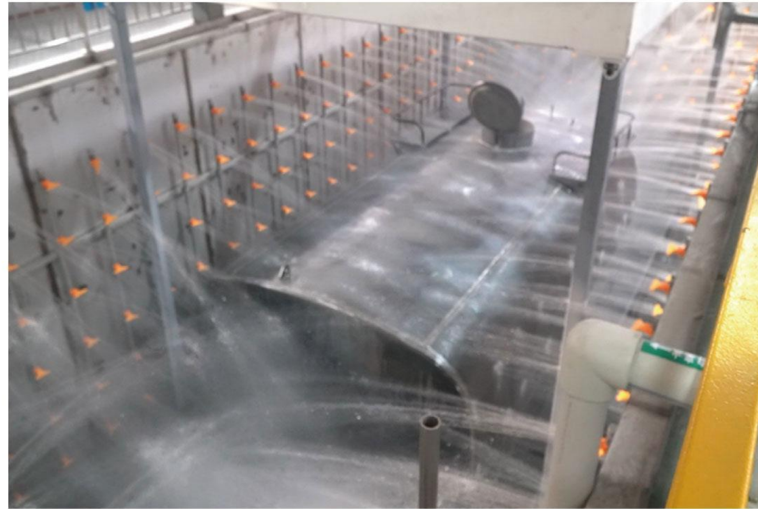
电泳涂装生产线-2
